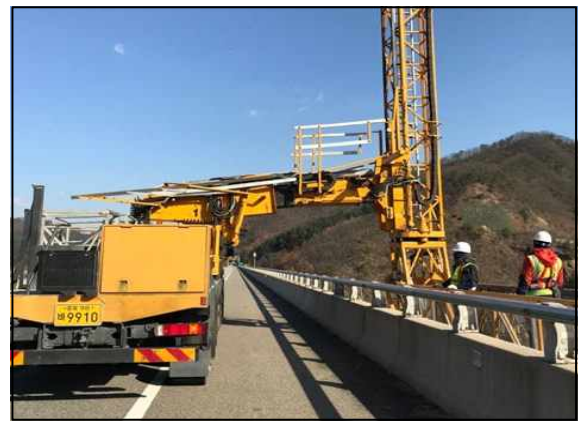
작업차량을 이용한 외관조사
