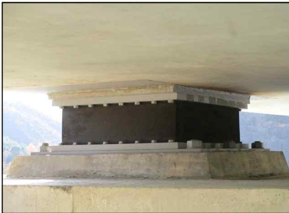
교량받침 전경(P6 SH2)
