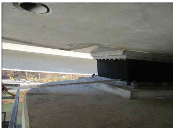
교량받침 연단거리 측정 현황
