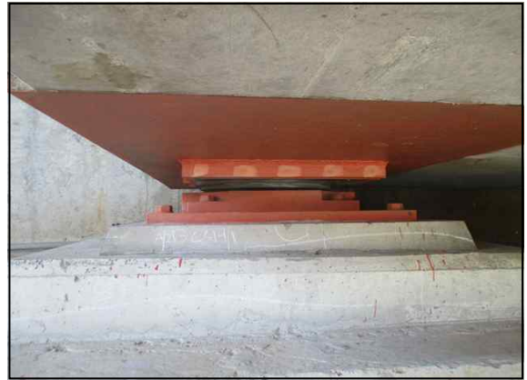
교량받침 전경(A2 SH1)
