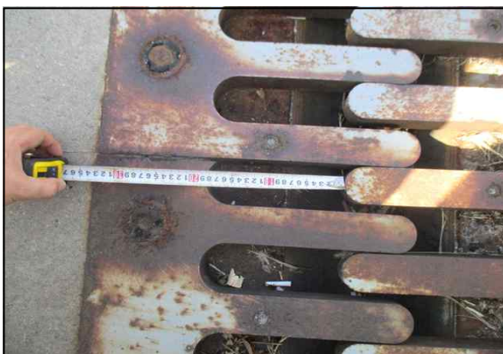
신축이음 상부 유간 전경(A1)
