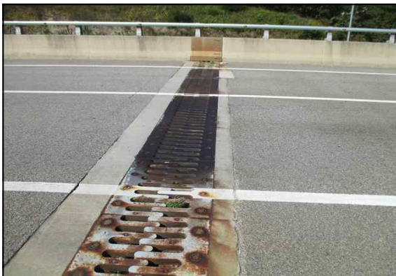
신축이음 상부 전경(A1)
