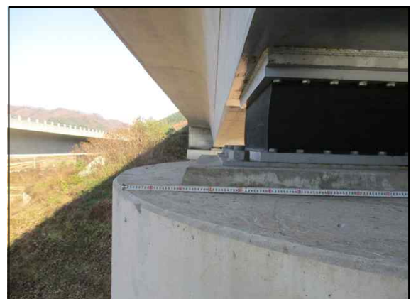
교량받침 연단거리 측정 현황
