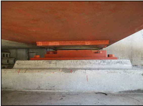
교량받침 전경(A1 SH1)
