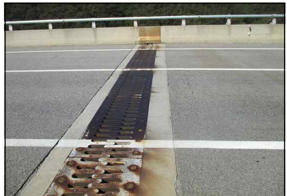
신축이음 상부 전경(A2)
