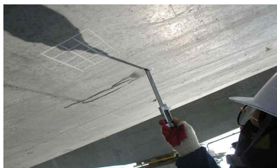
거더외부 탄산화 시험
