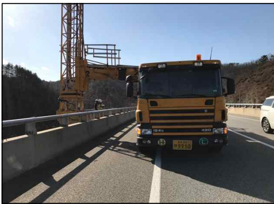
작업차량을 이용한 외관조사
