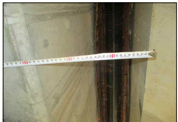
신축이음 하부 유간 전경(A1)
